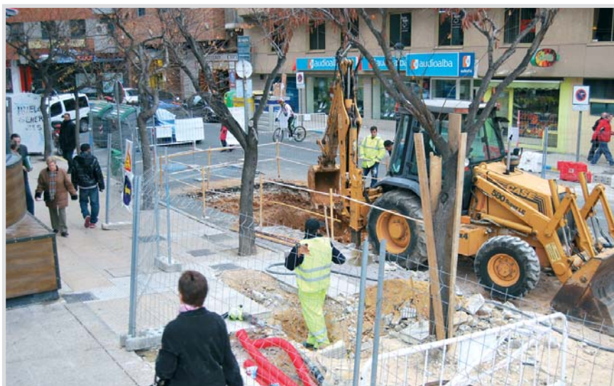
Arriba, obras para el soterramiento de los contenedores en la calle Carnicerías.
