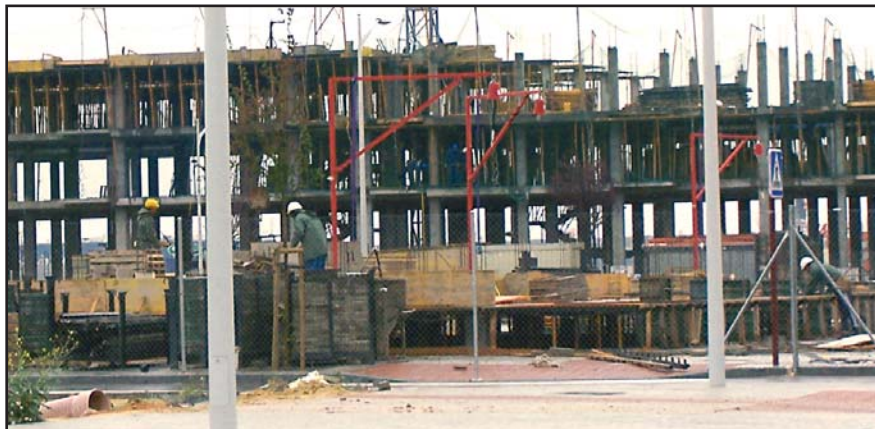
Construcción de viviendas en nuevos sectores de Albacete.
