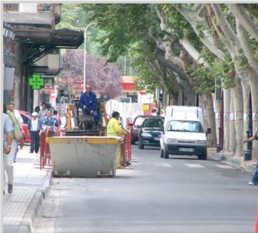
Obras en el Paseo de la Libertad.
