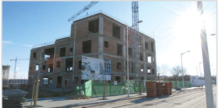
Obras de la nueva sede de Feda.
