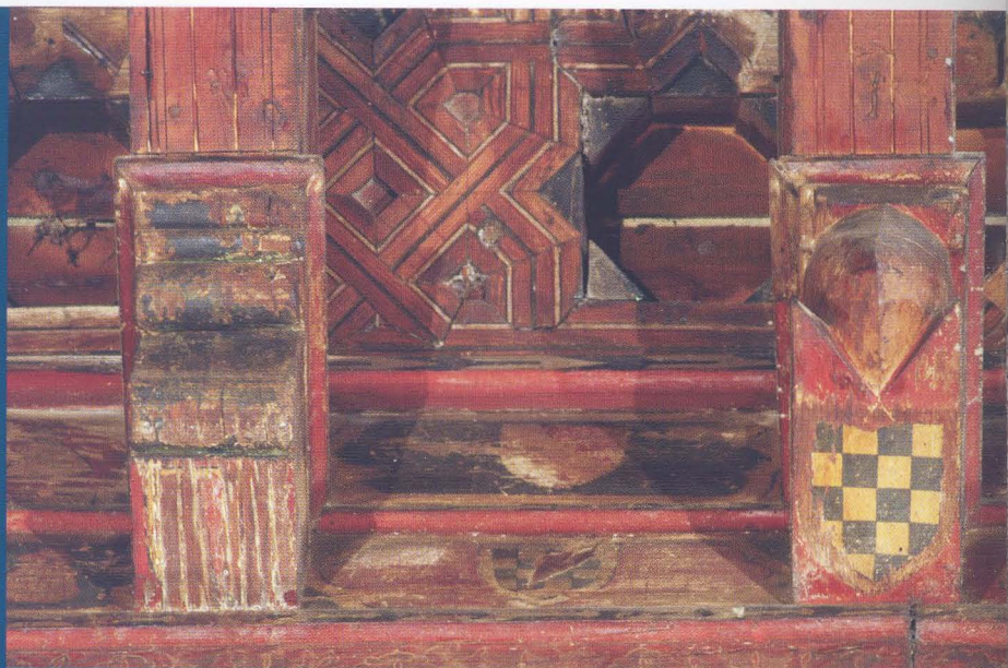
Fotografía antes de la restauración.
