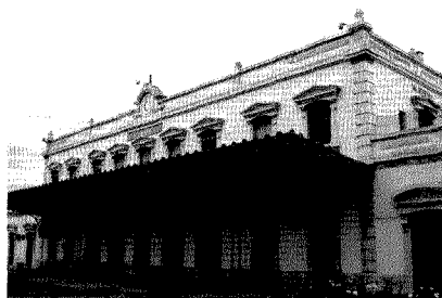
Fachada del edificio de viajeros hacia las vías.
