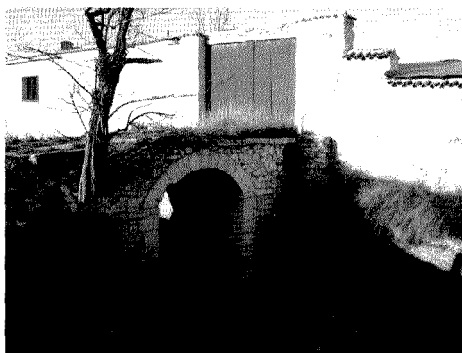
Puente sobre la vía del trenillo, interior y exterior de la nave de tinajas de “la Constancia”
