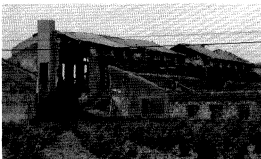
Vista del anterior horno antes de su demolición.
