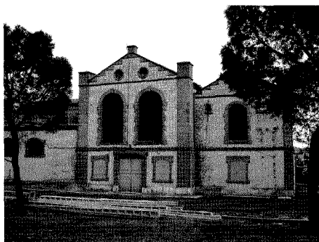
Central Eléctrica Centro España
