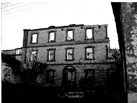
Fachada ruïnosa de Santa Teresa.
