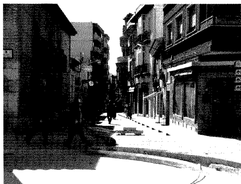
Imagen 12. Obras de peatonalización y mejora de la accesibilidad en el centro de Valdepeñas (Calle Real) (Autora: M. C. Cañizares)
