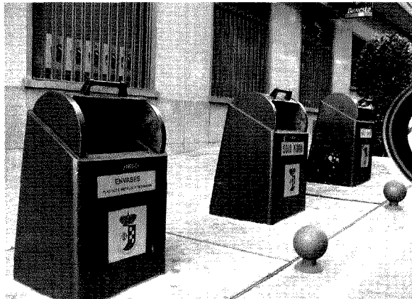
Imagen 6. Depósitos subterráneos para la selección de residuos en el centro de Valdepeñas (Autora. M. C. Cañizares)
