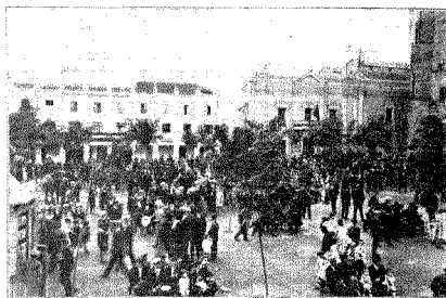
VALDEPEÑAS. Plaza en la época de la Constitución recientemente construida.
