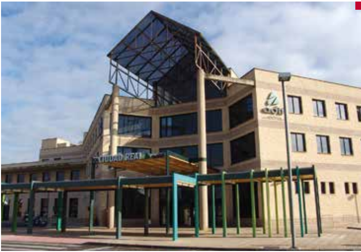
■ Estación de AVE en Ciudad Real.
