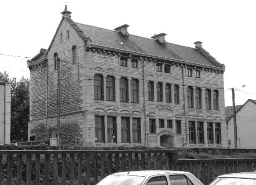
Figura 9. Fachada principal de la Maison d'école en Montceau-Les Mines.
