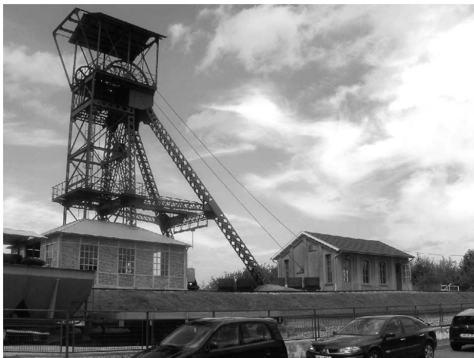
Figura 2. Pozo San Claudio y Sala de Máquinas.
