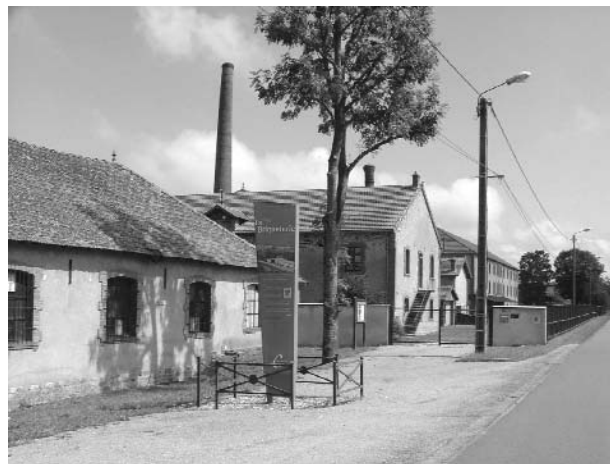
Figura 10. Fachada de la Briqueterie en Ciry-Le-Noble.
