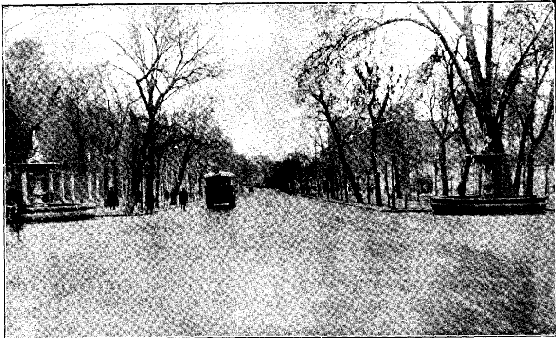
Paseo del Botánico, de Madrid, pavimentado con asfalto comprimido monolítico, en el año 1923
