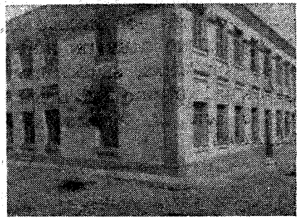
Fachada del magnífico Grupo Escolar de Porzuna
