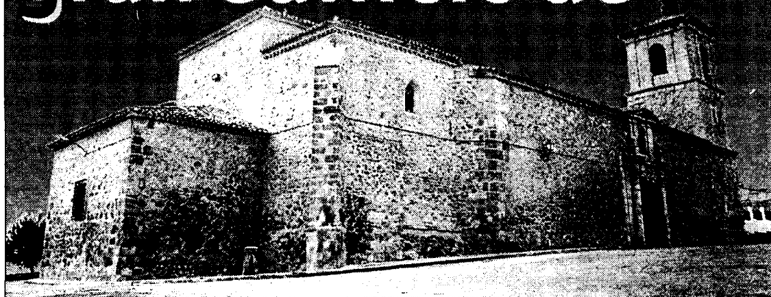
SANTO DOMINGO DE SILOS. Iglesia Parroquial de Montalbo, con planta rectangular y sacristía saliente.
