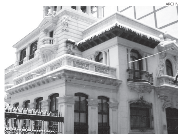
Fachada de la Cámara de Comercio de Albacete.
