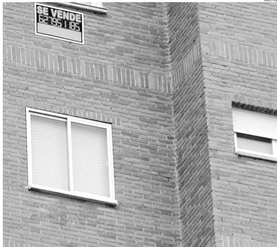
La venta de viviendas no termina de despegar.
