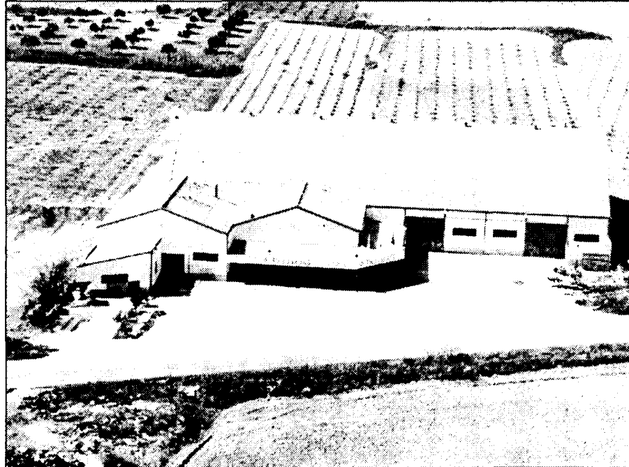
Una imagen de archivo de las instalaciones de Faremag, en Madrigueras.
