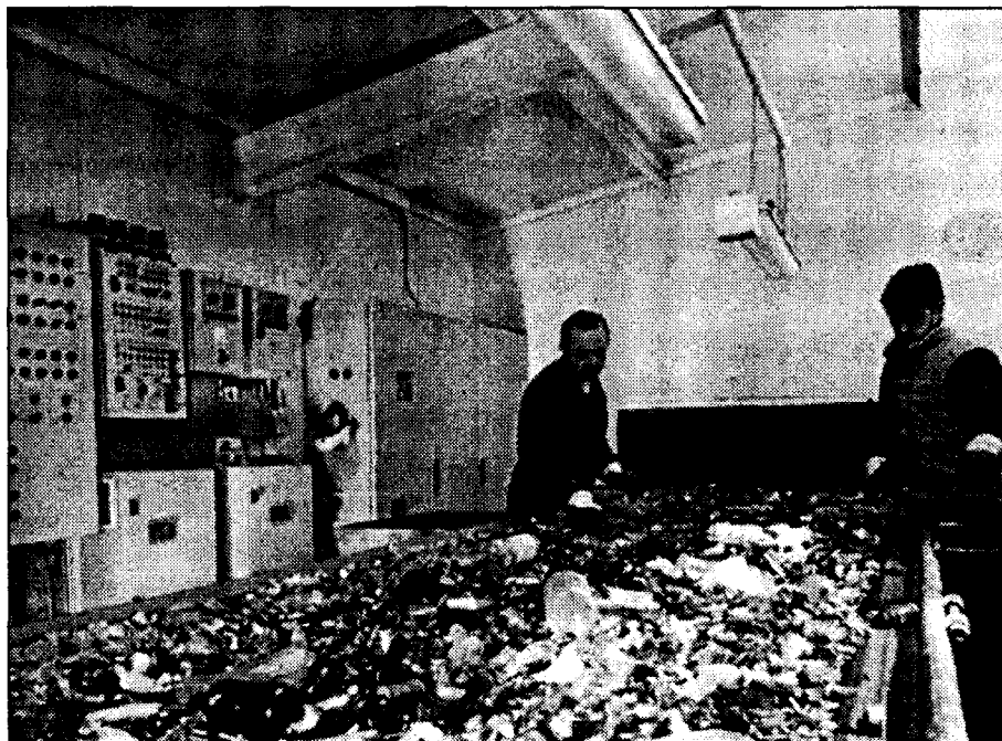
La comunidad cuenta con varias plantas de selección y compostaje para el reciclado.
