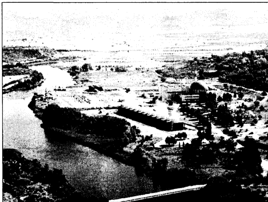
La central de José Cabrera, en Zorita, es la más antigua de España en funcionamiento.
