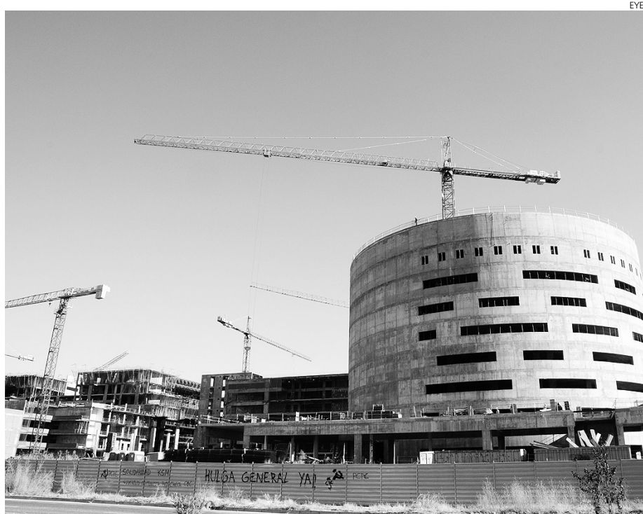
El nuevo hospital de Toledo se encuentra ejecutado al 30%.
