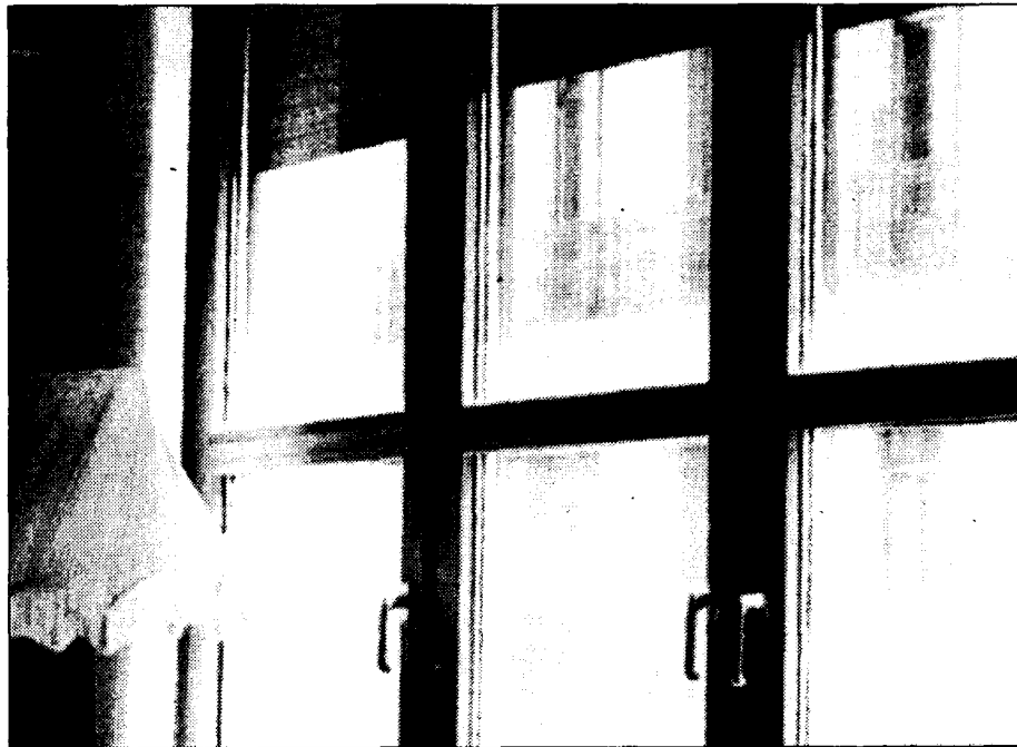
Las ventanas de Euro-System son mixtas, fabricadas en aluminio en el exterior y madera por dentro.
