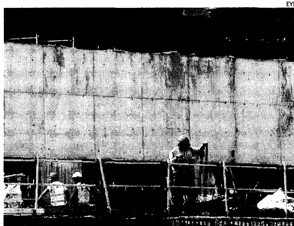
La construcción, un sector que suele sufrir accidentes.
