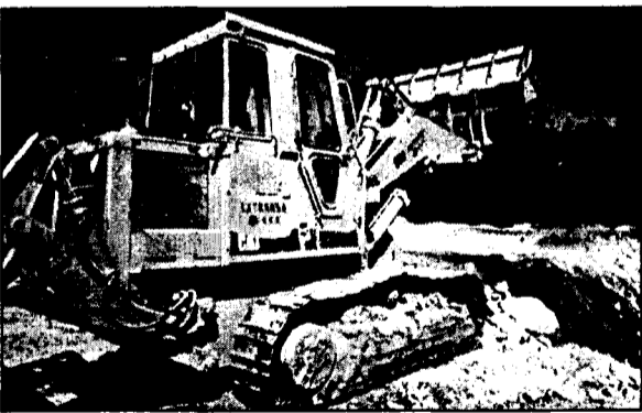
Dispone de quince máquinas excavadoras, que renueva todos los años.
