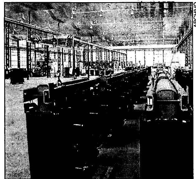
Los nuevos transformadores abastecerán una línea de 45.kw.
