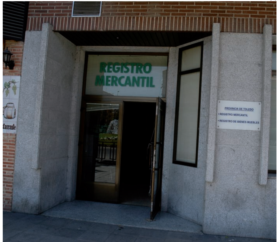
Edificio del Registro Mercantil de Toledo capital.
