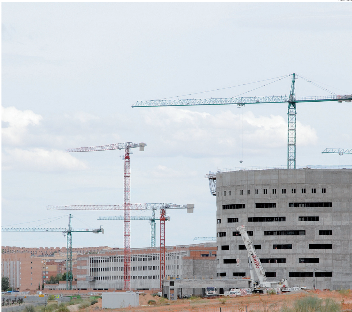
El boom de la construcción ha ocasionado que todas las empresas relacionadas con el sector estén en mal momento.
