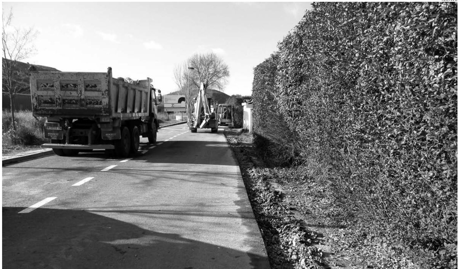
La construcción ha proporcionado importantes ingresos a los municipios.
