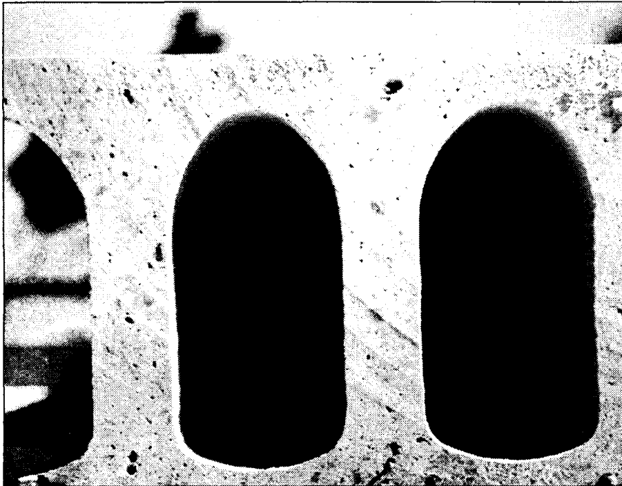
La empresa produce una media anual de 50.000 metros lineales de tubos de hormigón en masa.
