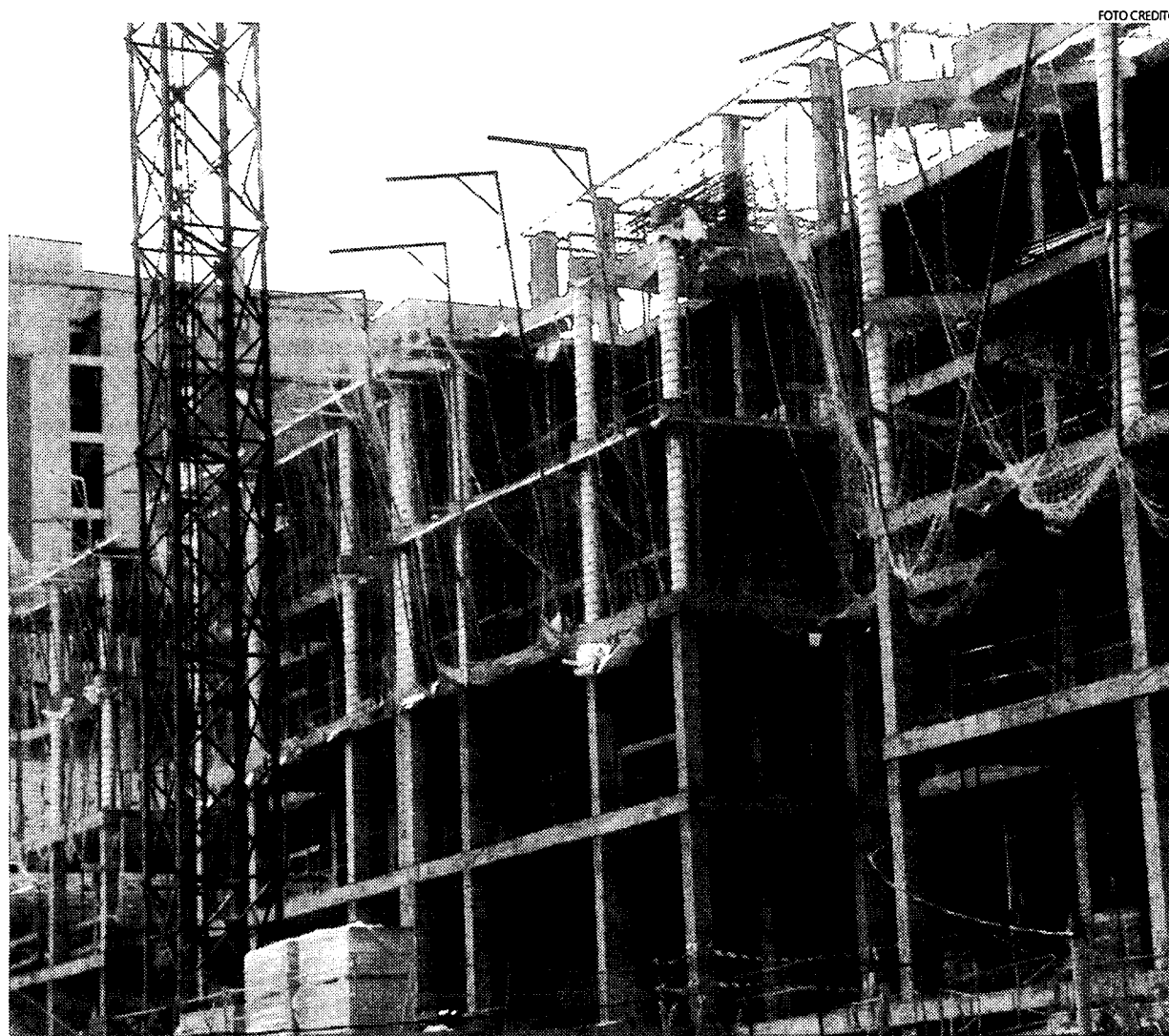
Construcción es el sector que más trabajadores ha perdido en el último año.
