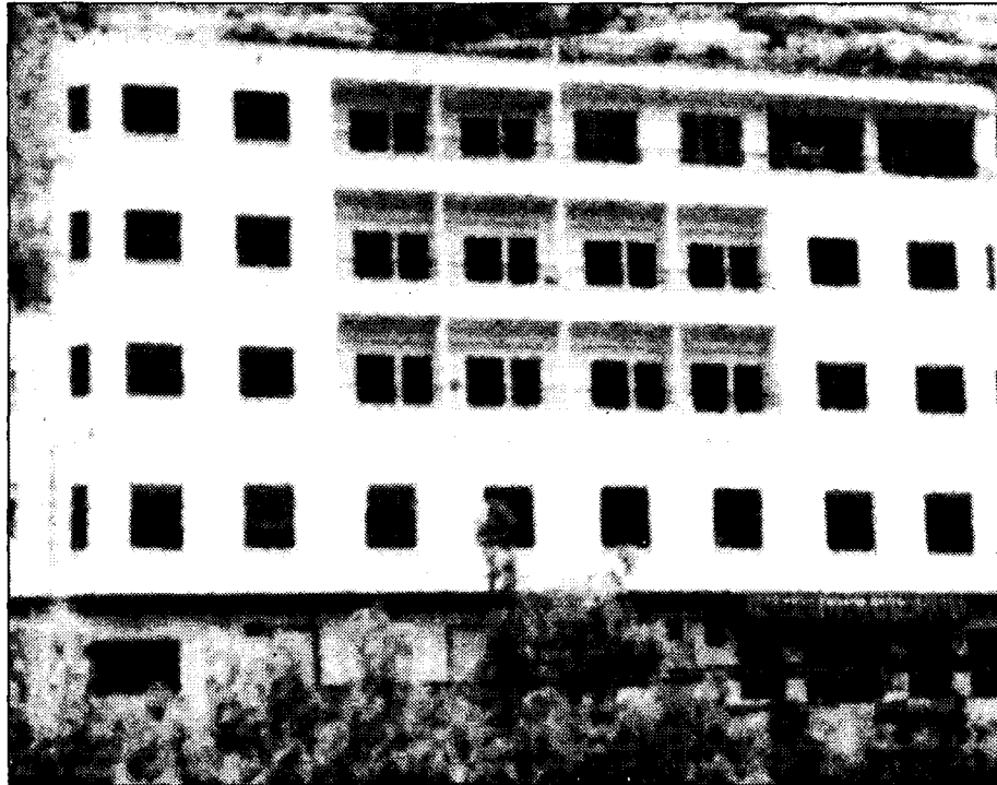
Las habitaciones del Hostal Plaza tienen calefacción, teléfono y aire acondicionado, entre otros servicios.
