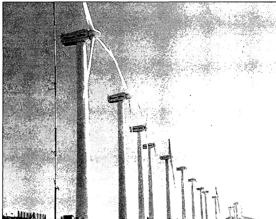
Este parque eólico que comenzará a construirse a finales de 2000 tendrá una potencia de 13,2 Mw.
