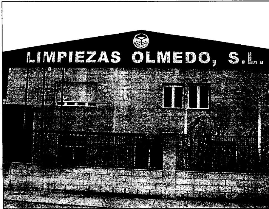
En la imagen, las instalaciones de Limpiezas Olmedo en Tomelloso (Ciudad Real).
