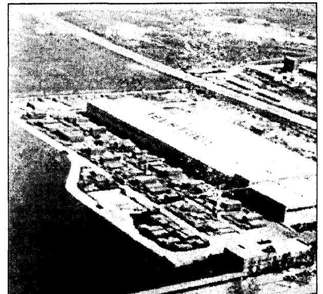
Ibertubo está ubicada en el polígono industrial de Toledo.
