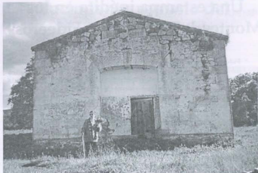
Ruinas del convento de El Castañar. La iglesia o ermita grande.
