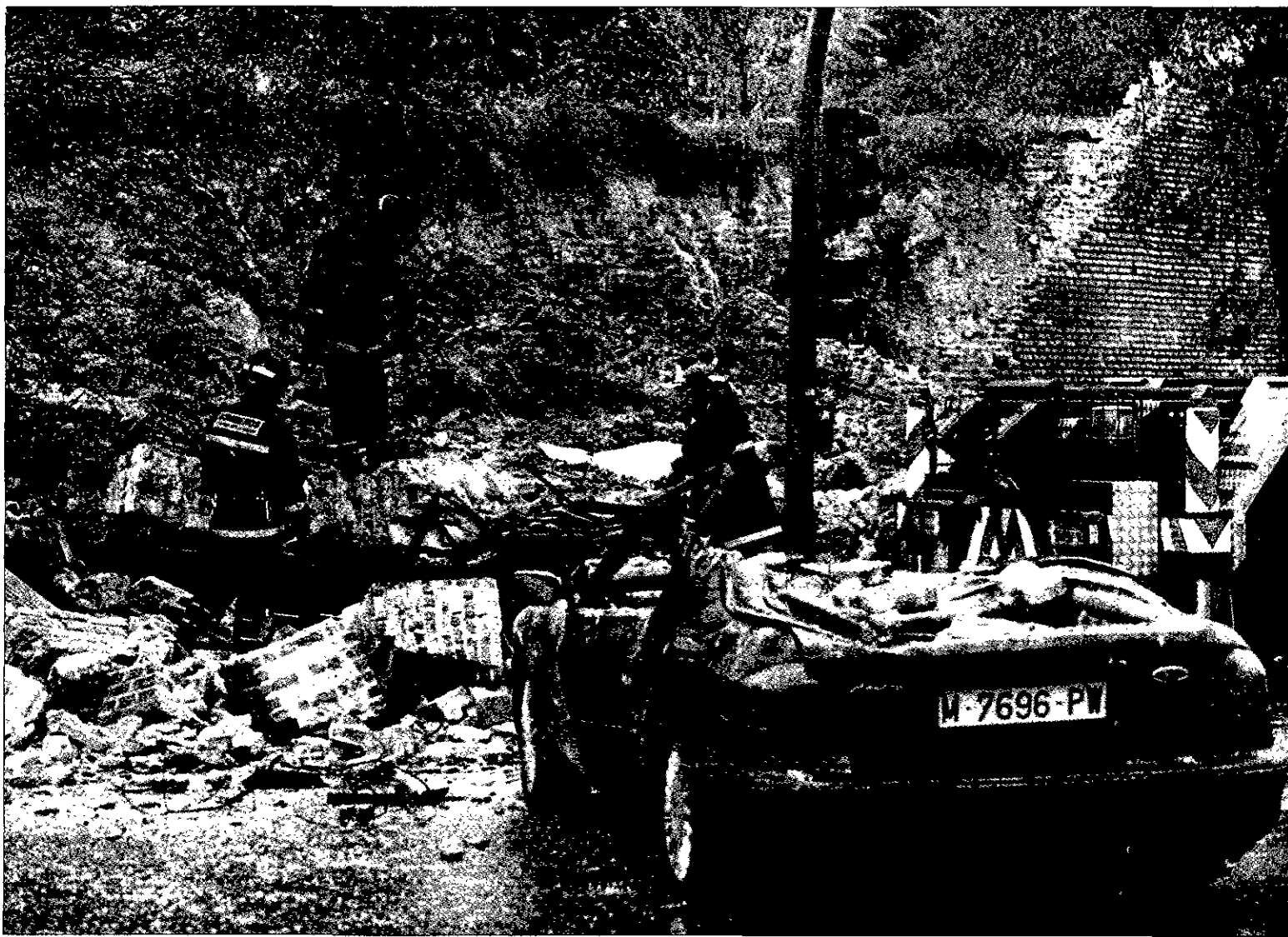
EL MURO SE HUNDIÓ Las fuertes lluvias que cayeron ayer en Madrid derrumbaron la tapia del colegio Sagrados Corazones que aplastó ocho coches.
