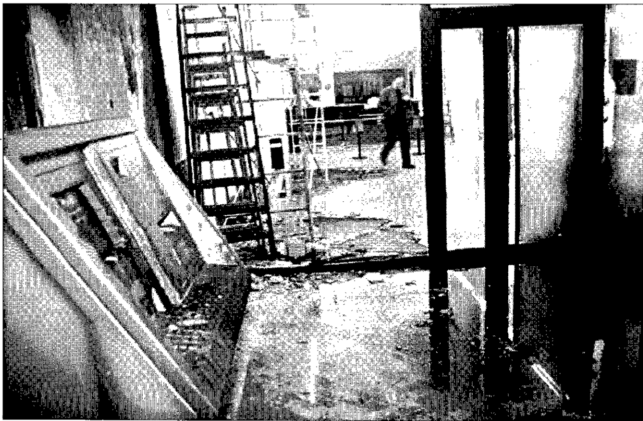
DESOLACIÓN Aspecto de una de las dos sucursales bancarias de San Sebastián que fueron atacadas ayer por los radicales.
