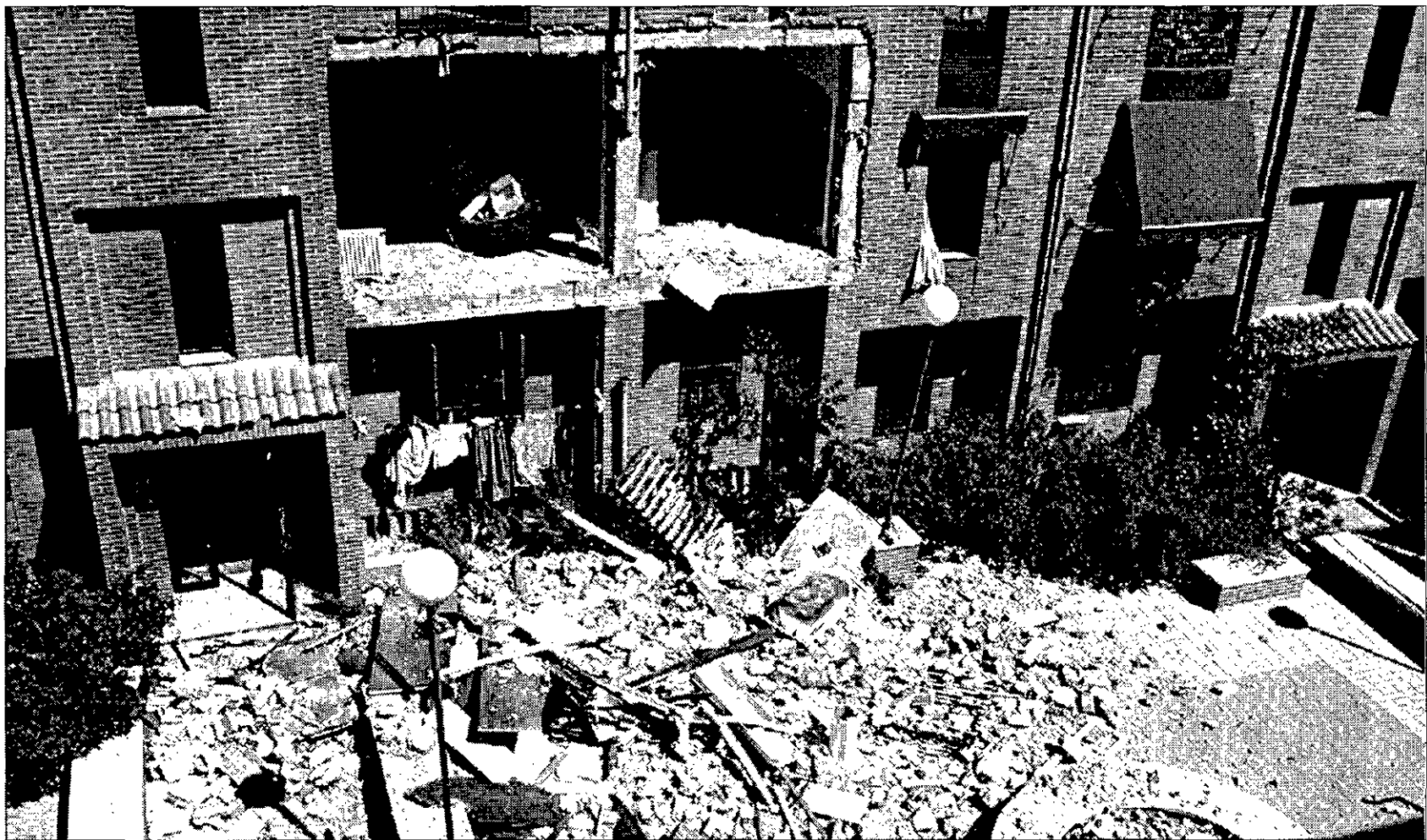
EXPLOSIÓN Un escape de gas ocasionó este desastre en una vivienda en el barrio de Villaverde, en Madrid.
