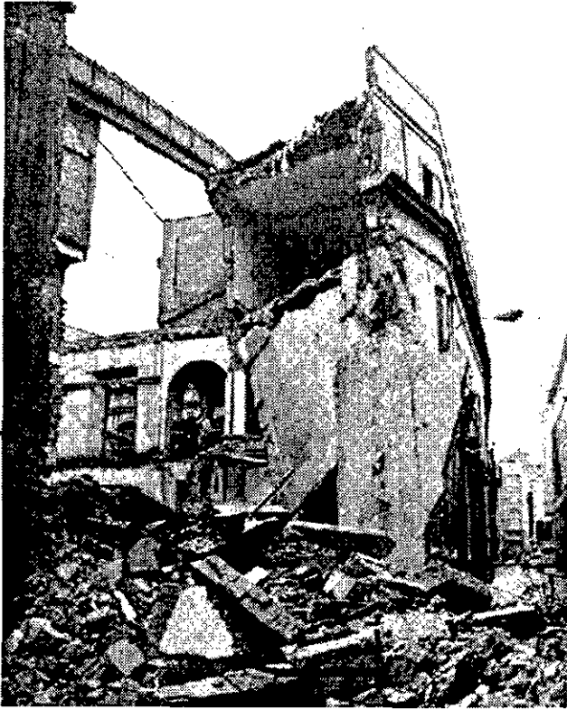
DESTRUIDO El viento afectó a un edificio del siglo XVIII de Valladolid.
