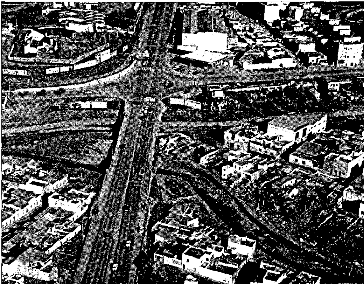
EXCESIVA ESPECULACIÓN Vista aérea de la barriada Cerro de los Reyes (Badajoz) en la que se aprecia su ubicación en la confluencia de dos arroyos.
