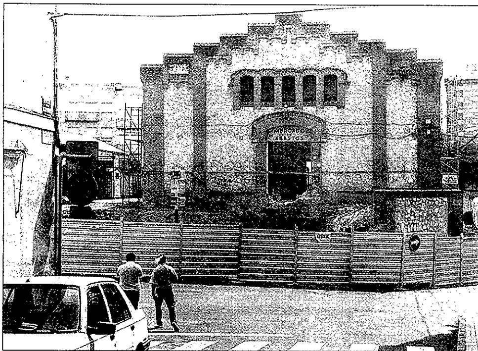
Después del casi tres años de obras, el mercado de abastos abrirá sus puertas a mediados de octubre.
