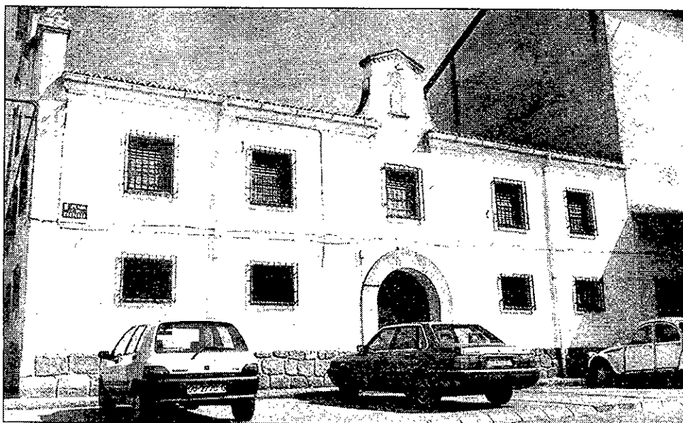
El futuro del convento de Ntra. Sra. de la Asunción permanece en el aire.
