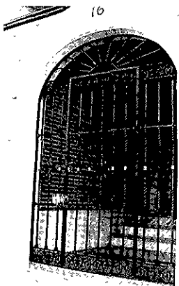
Carpintería Metálica y Cierres de Seguridad
