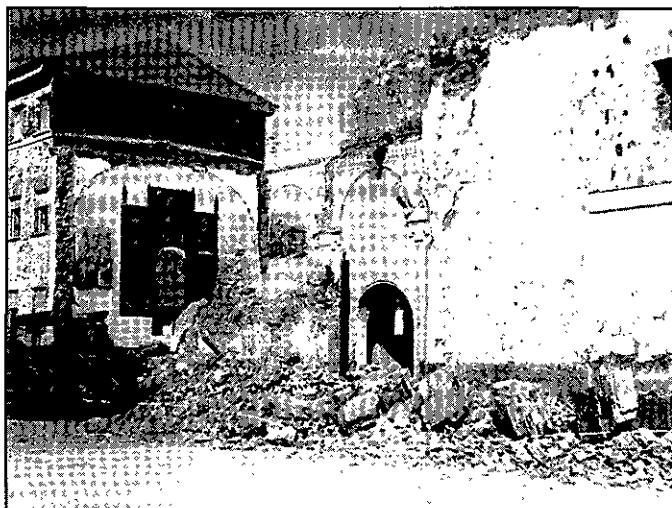
Momento del derribo de la que fue Capilla de La Milagrosa
