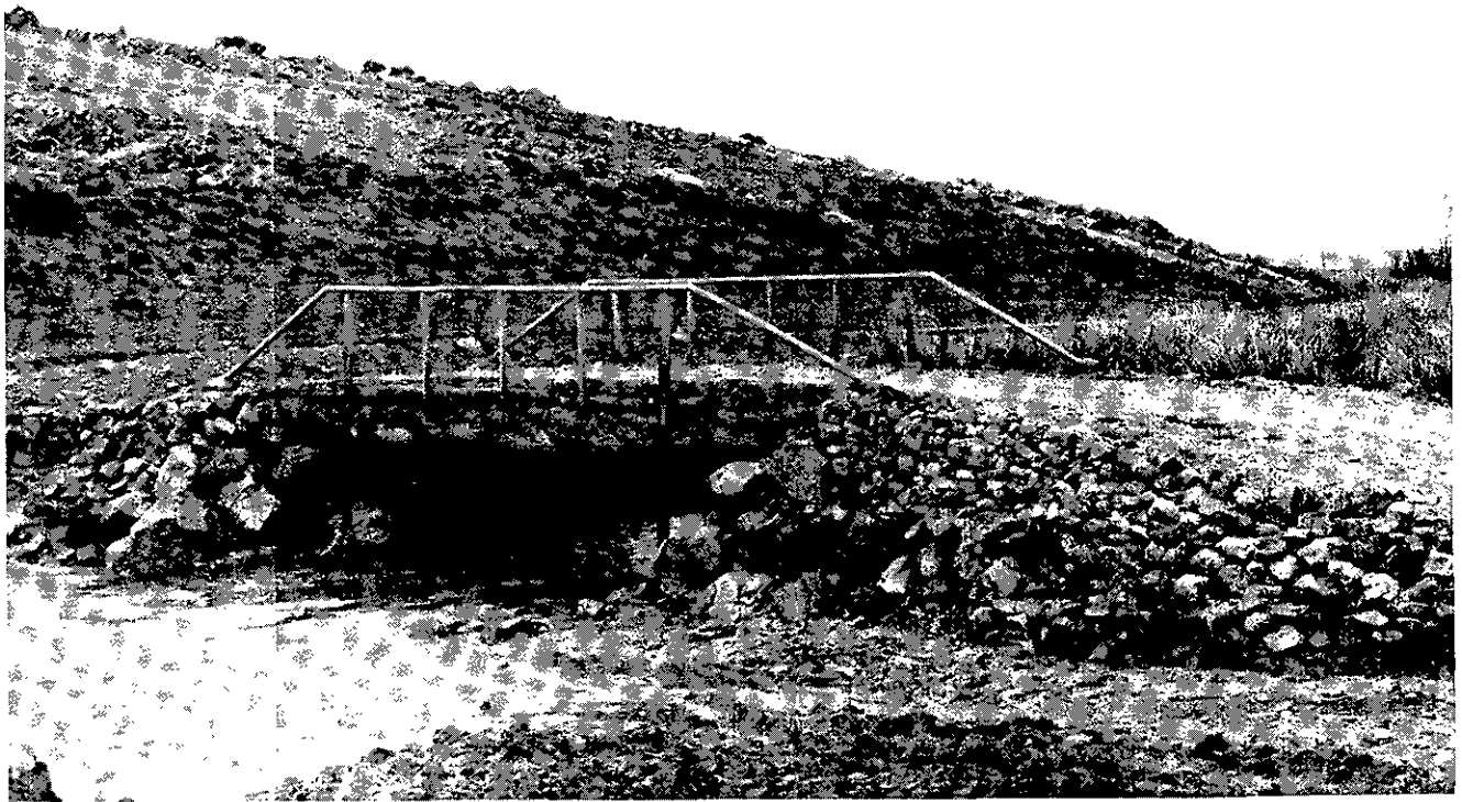
Puente sobre el río Azuer en el Puerto Vallehermoso, cerca de Infantes
