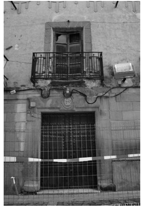
Puerta principal del edificio en c/ Mayor
