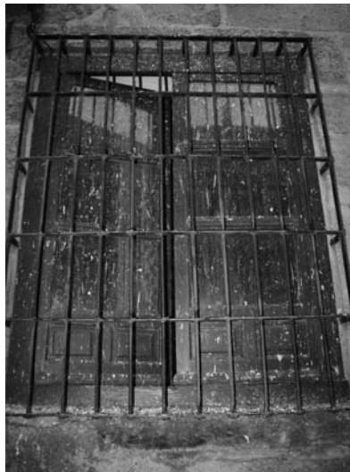
Una de las ventanas en la que se aprecia el daño que causan las palomas
