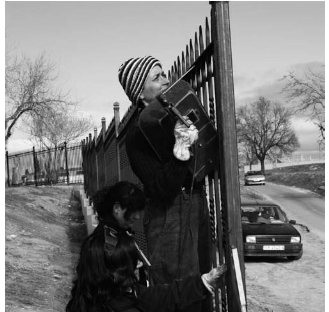
Participantes en el Taller de Empleo Francisco de Quevedo III trabajando en el cerramiento del recinto de San Antón
