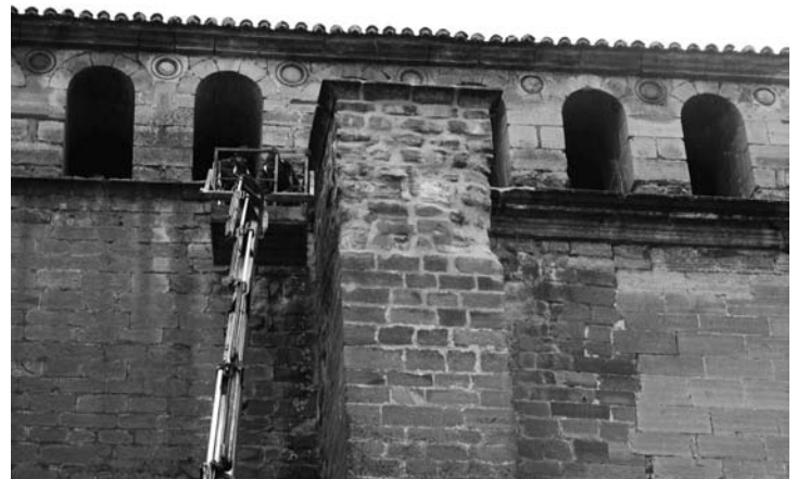
Dos obreros de la empresa Juebeba retocan las partes deterioradas del muro y contrafuerte de la cara norte
