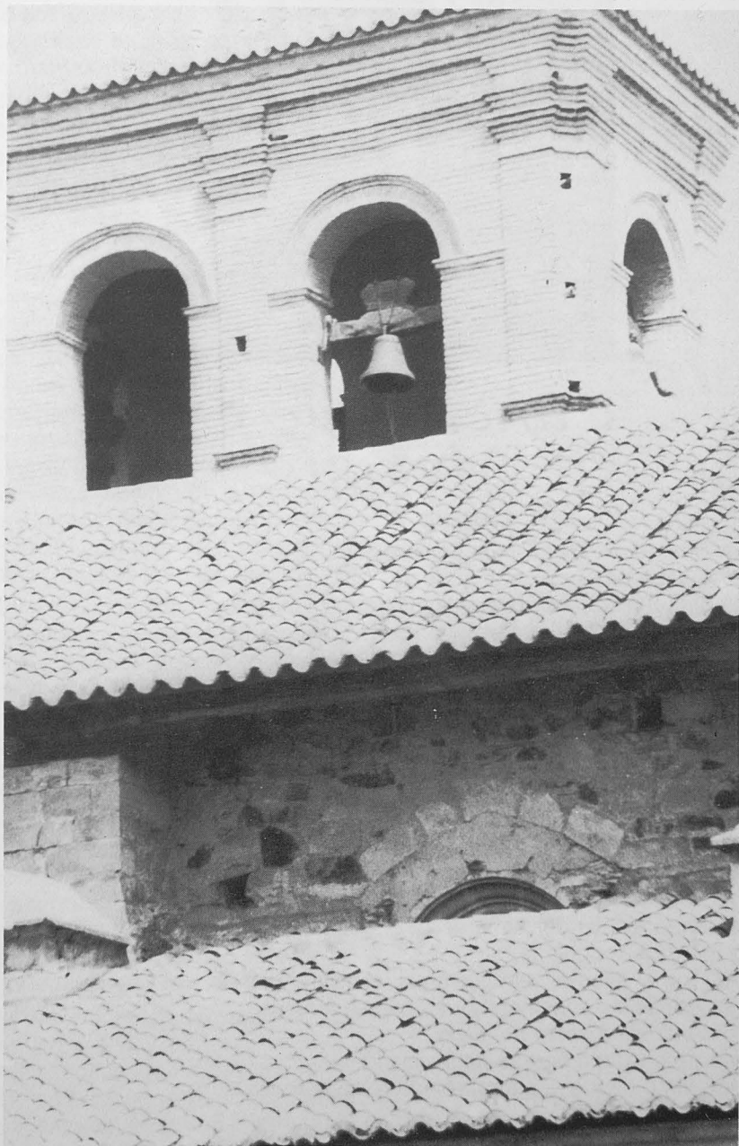
Detalle de la Torre del Convento de los Dominicos
