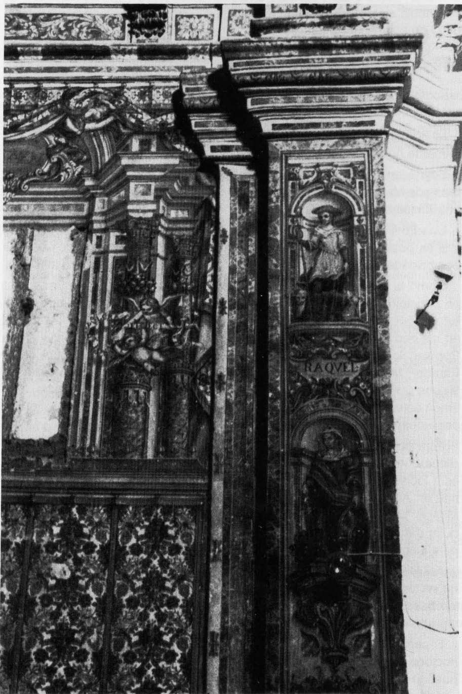
Detalle interior de la Iglesia de San Agustín, en la que se observan el buen estado de las pinturas, que en la última fase de la obra de restauración, serán recuperadas en su totalidad.
