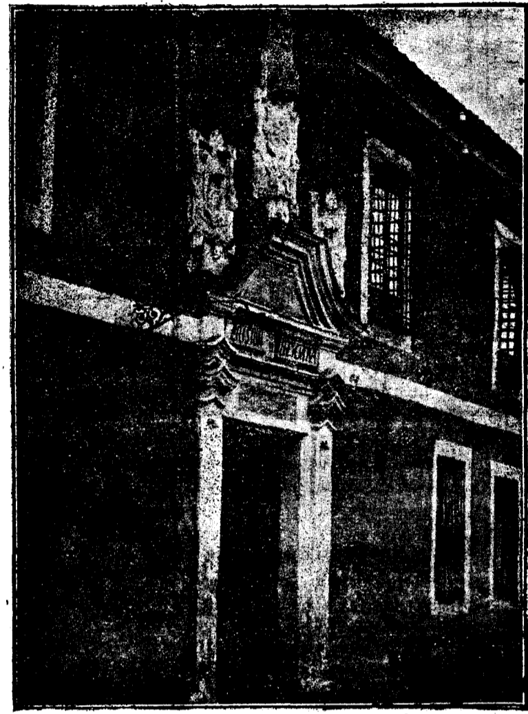
Vista de la fachada de la Cárcel. (Fot. Sánchez)
