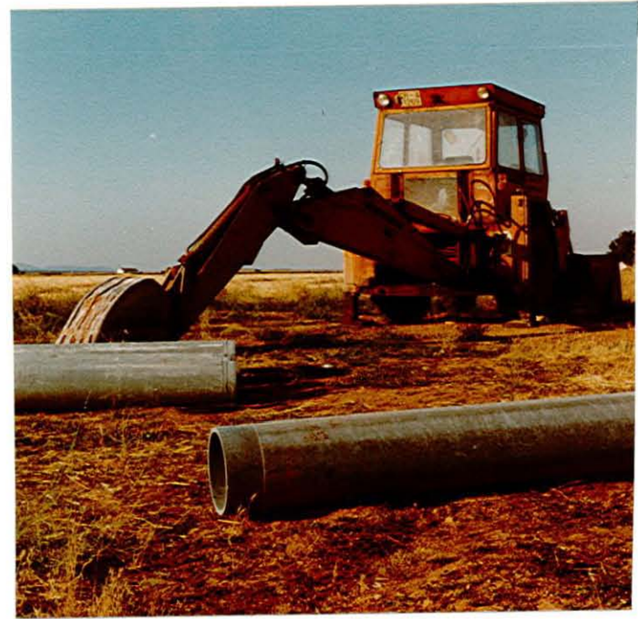
LA ESCAVADORA REPOSA TRAS REALIZAR LA ZANJA PARA LA TUBERIA DE EMPALME
