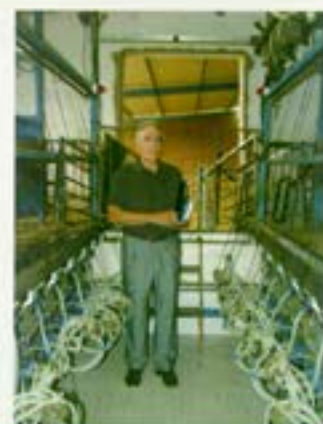
D. José Luis, en la sala de ordeño de su explotación, en la que acaban de instalar mejoras, como los medidores electrónicos.
