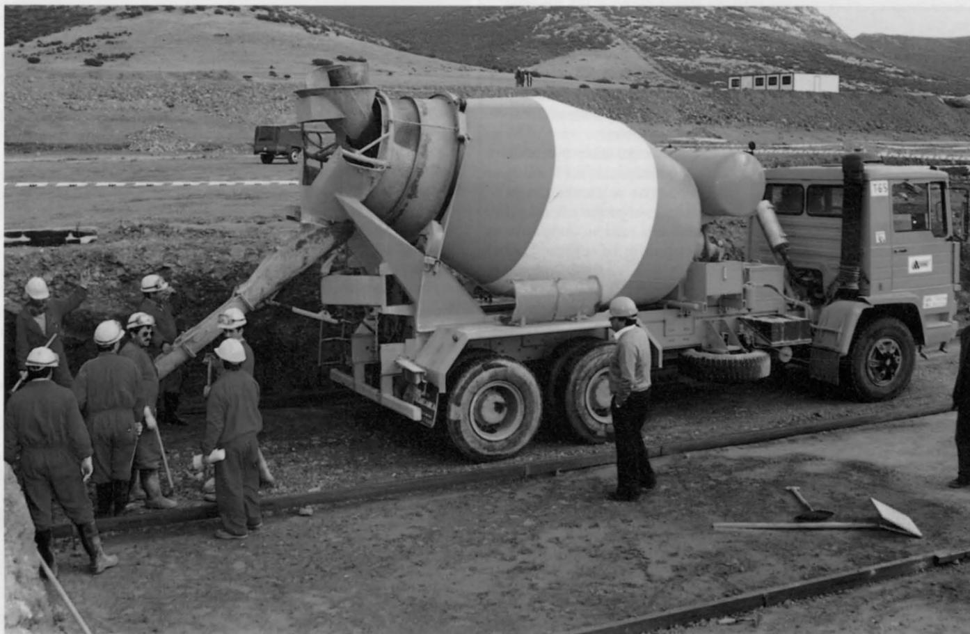
El primer camión hormigonera deposita el cemento para contruir los pilares del edificio sobre el que se asentará la turbina de gas
