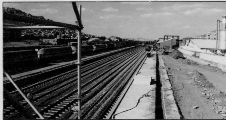
Vista general de las obras de la nueva red de vías y andenes para el AVE.
